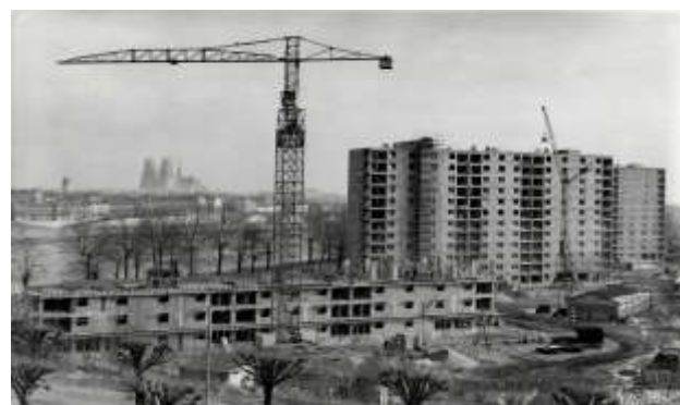
Figure 37 : Trévisse en construction, Logem Loiret
