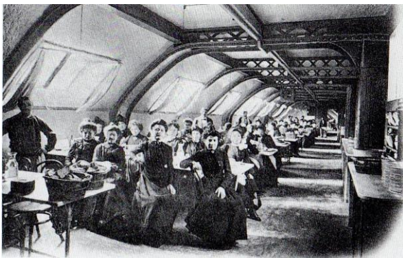
Salle à manger des employés femmes du Printemps. Ces dernières disposent, dès l'origine, d'un réfectoire séparé de celui des hommes
